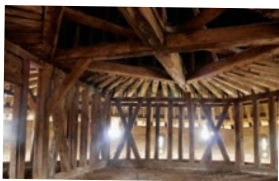
Remarquable charpente en chêne de la Tour Zizim.
